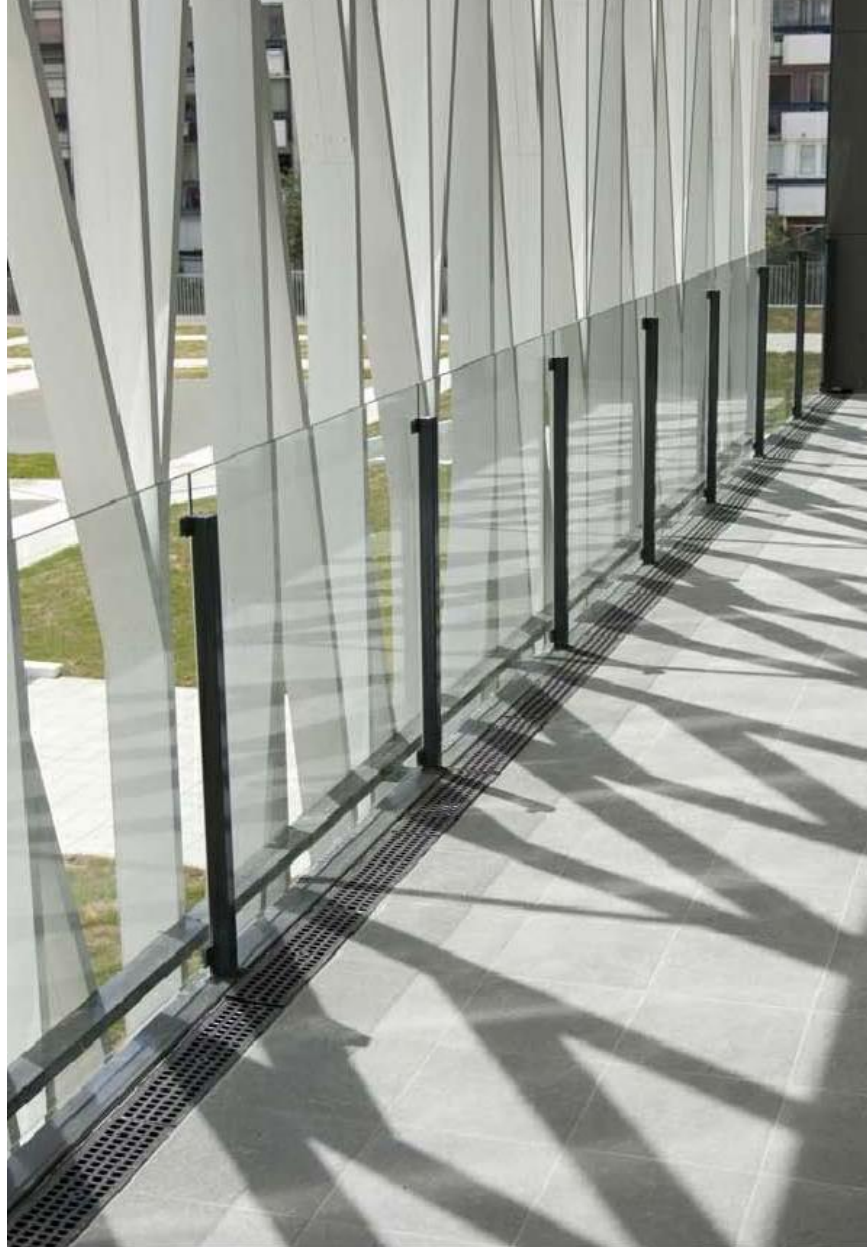
Комбинована дечија установа „Драган Лаковић“, блок 61, Нови Београд. Аутори: АГМ архитекти- Борислав Петровић, Иван Рашковић, Нада Јелић, Никола Стојковић, Лука Остојић. Коаутори у изради идејног решења: Александар Томић и Анђелка Мурић
