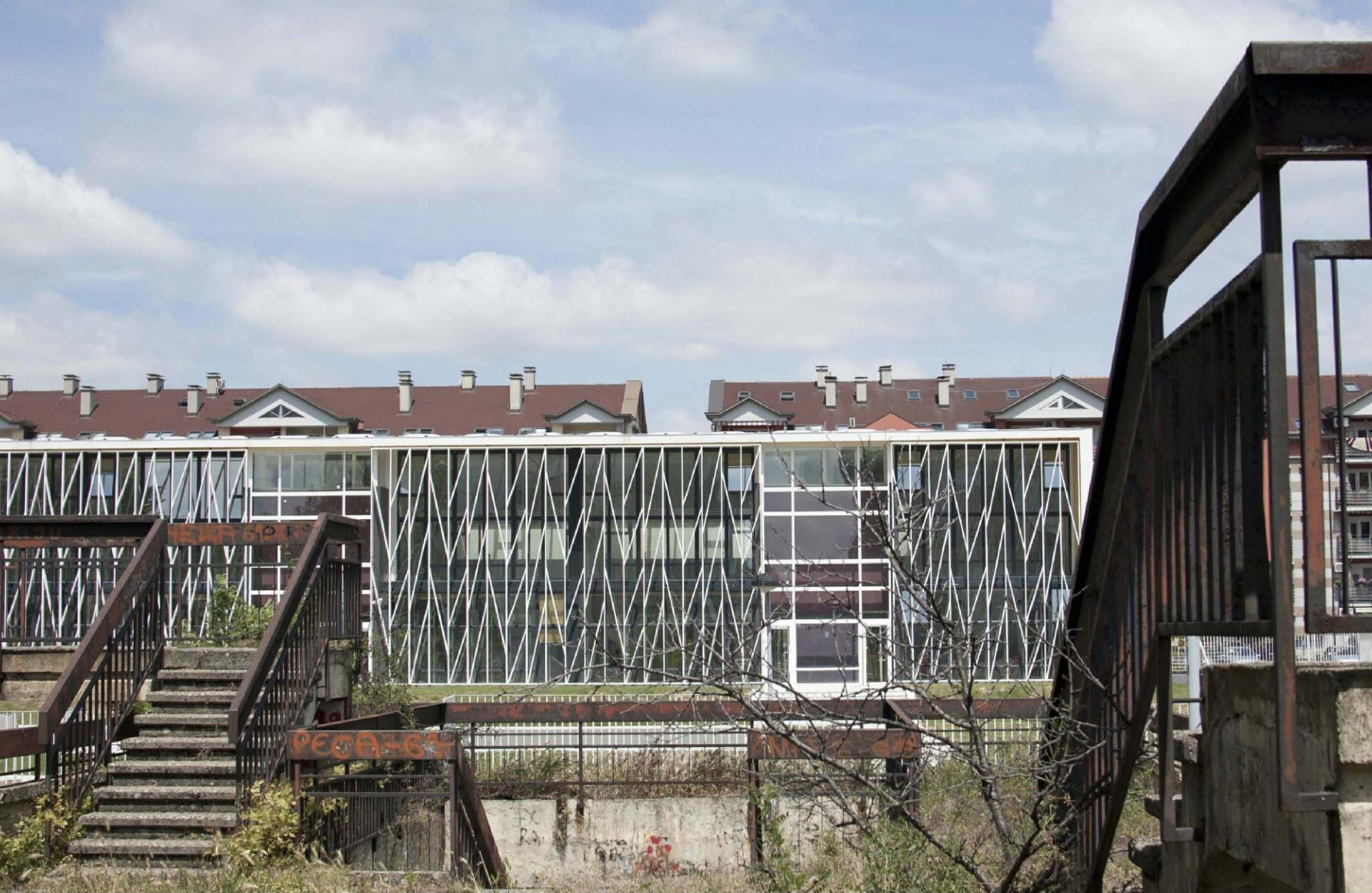
Комбинована дечија установа „Драган Лаковић“, блок 61, Нови Београд. Аутори: АГМ архитекти- Борислав Петровић, Иван Рашковић, Нада Јелић, Никола Стојковић, Лука Остојић. Коаутори у изради идејног решења: Александар Томић и Анђелка Мурић
