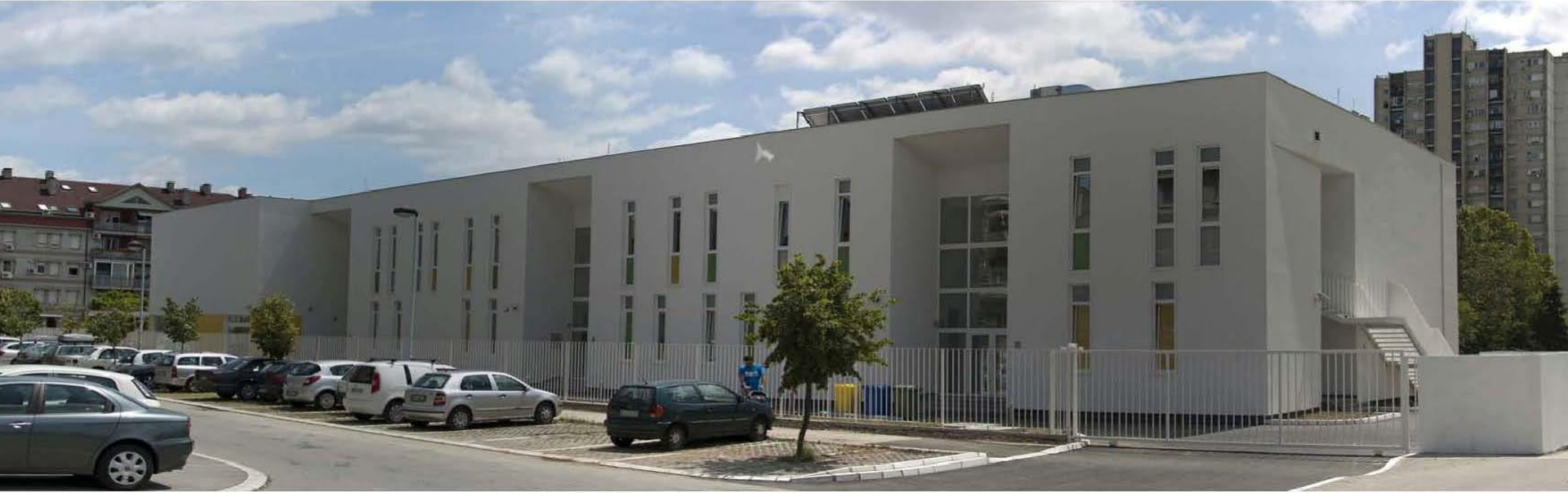
Комбинована дечија установа „Драган Лаковић“, блок 61, Нови Београд. Аутори: АГМ архитекти- Борислав Петровић, Иван Рашковић, Нада Јелић, Никола Стојковић, Лука Остојић. Коаутори у изради идејног решења: Александар Томић и Анђелка Мурић
