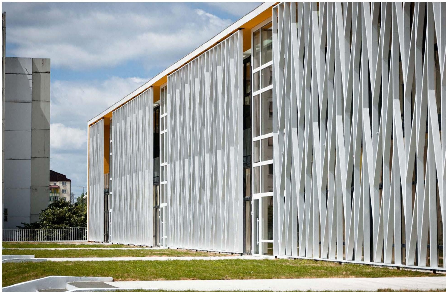
Комбинована дечија установа „Драган Лаковић“, блок 61, Нови Београд. Аутори: АГМ архитекти- Борислав Петровић, Иван Рашковић, Нада Јелић, Никола Стојковић, Лука Остојић. Коаутори у изради идејног решења: Александар Томић и Анђелка Мурић
